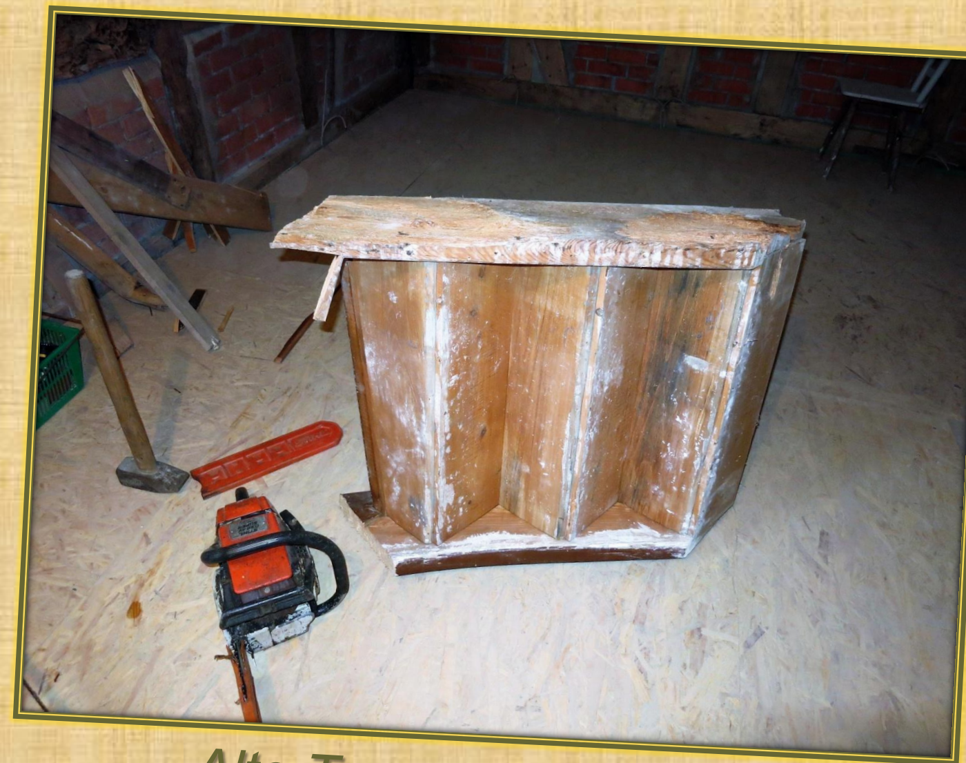
Alte Treppe zum DG (3)
