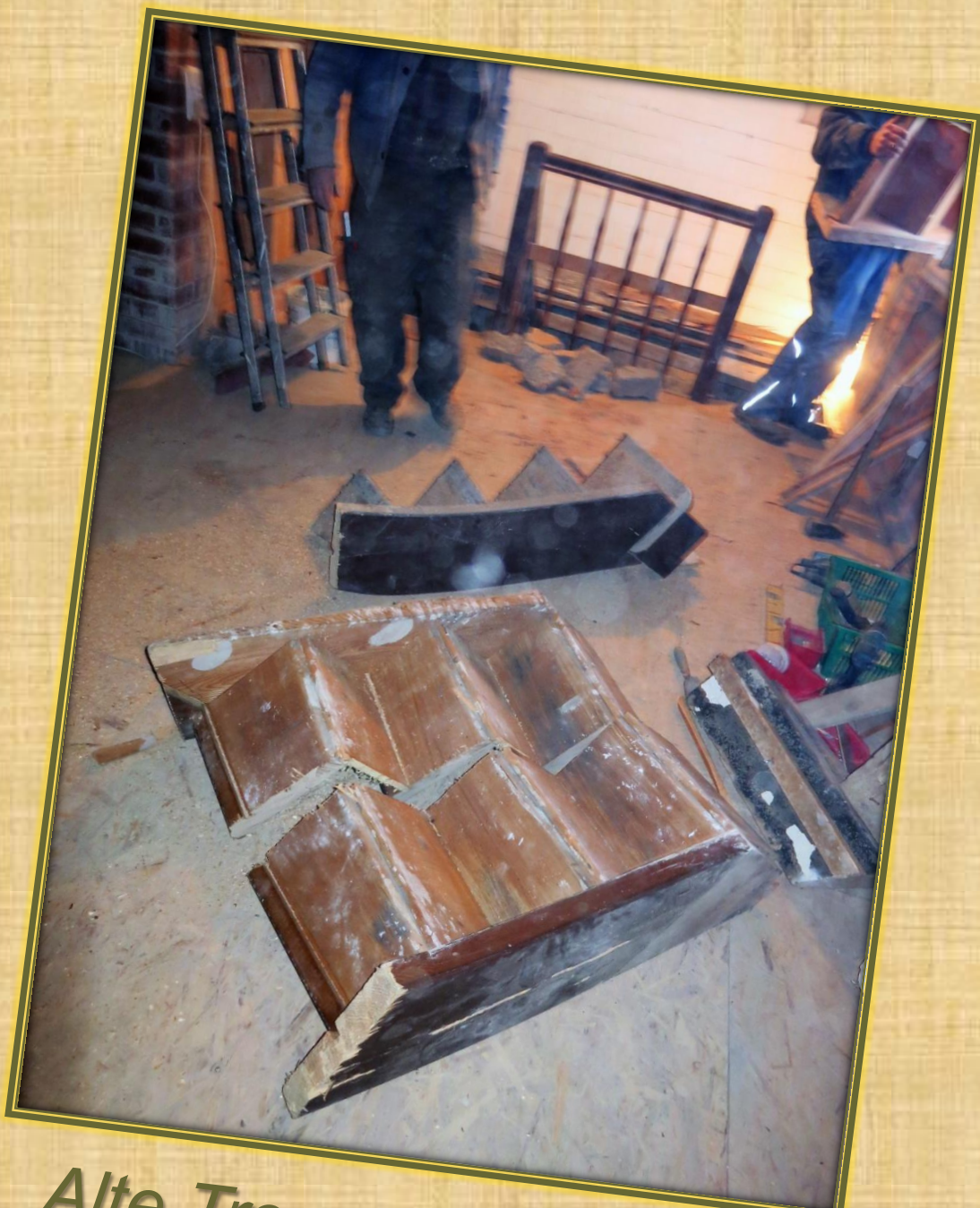
Alte Treppe zum DG (5)
