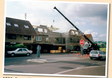
1995: Baustelle Michel, Aufenauer Str. 2
