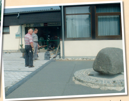
2002: Pflasterarbeiten, KH Müller und Gerhard Seitz
