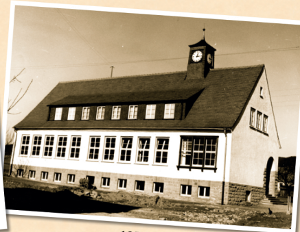
1951: Das fertige Schulgebäude
