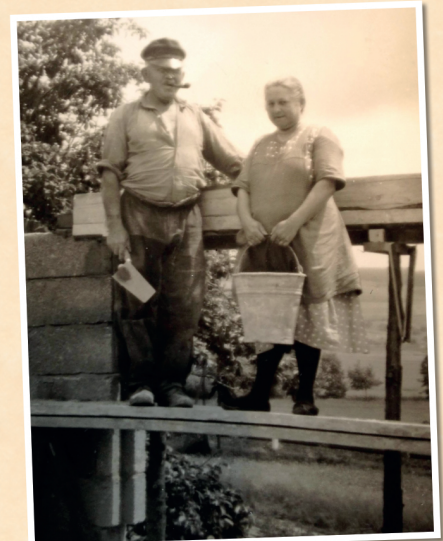
Meine Eltern Josef und Katharina Ritzel auf der Baustelle unseres Hauses.
