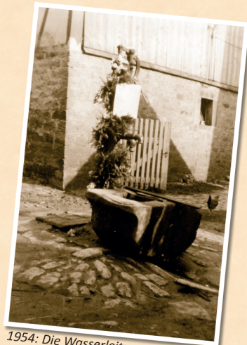
1954: Die Wasserleitung wurde verlegt. Der Dorf-Brunnen hat ausgedient.
