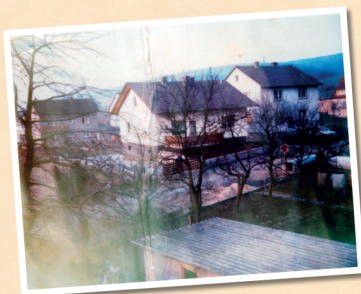
Kanalbau Neue Straße
